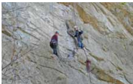
Arbeitseinsatz an der Plattenwand
